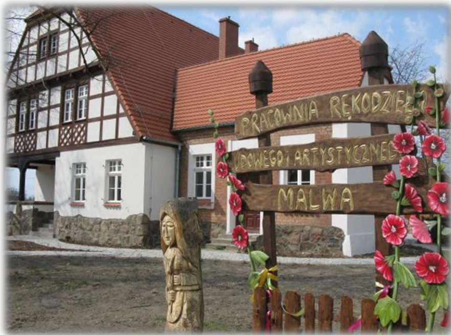
Remont świetlicy wiejskiej w Zelgnie
